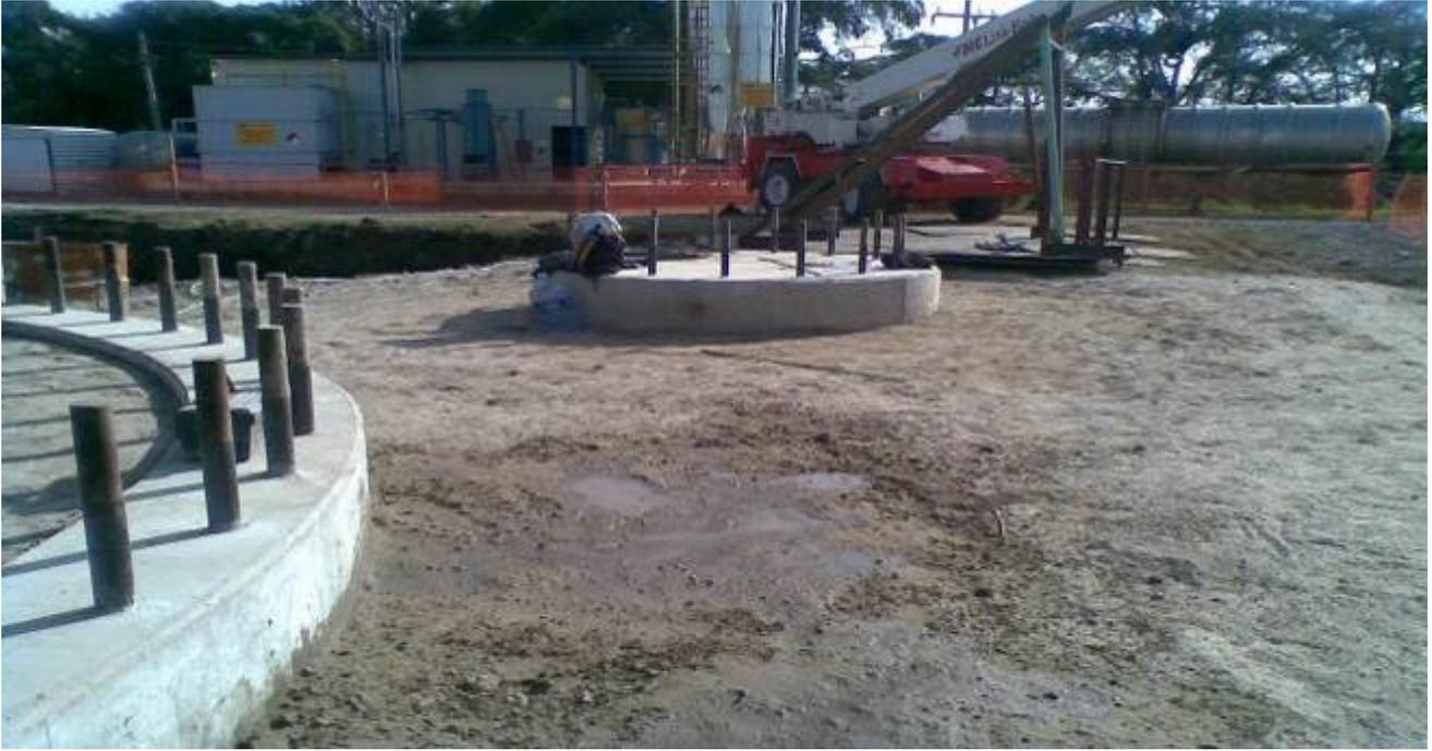
***Cimentación de tanques verticales para reactores anaerobios***
