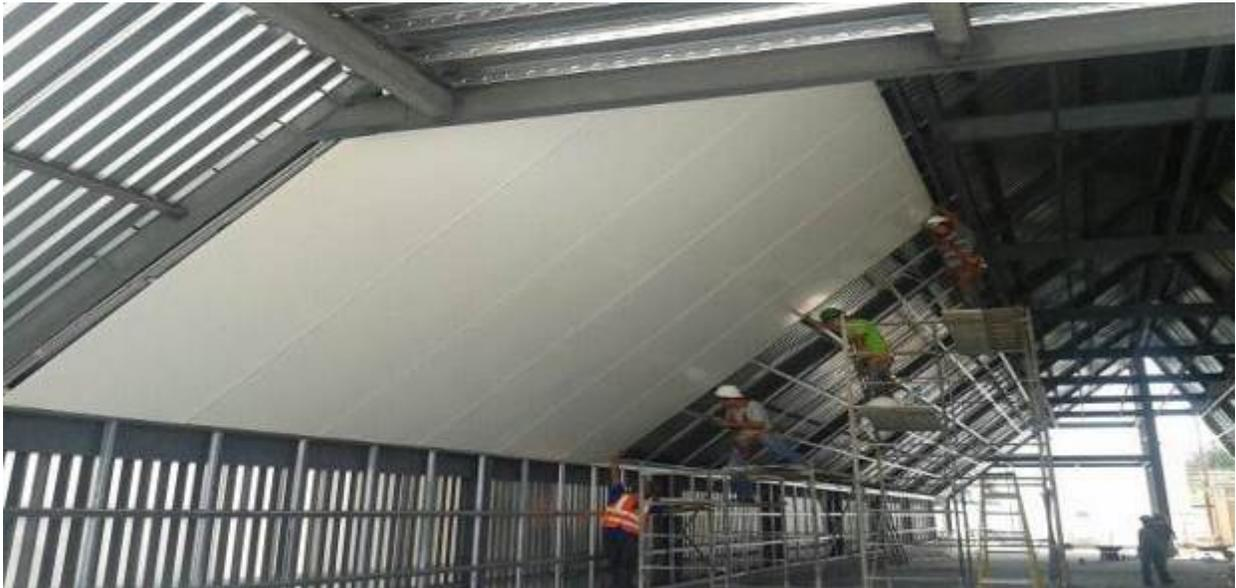
***Recubrimiento interior con Paneles de Superwallclean XPS foamar y FRP***
