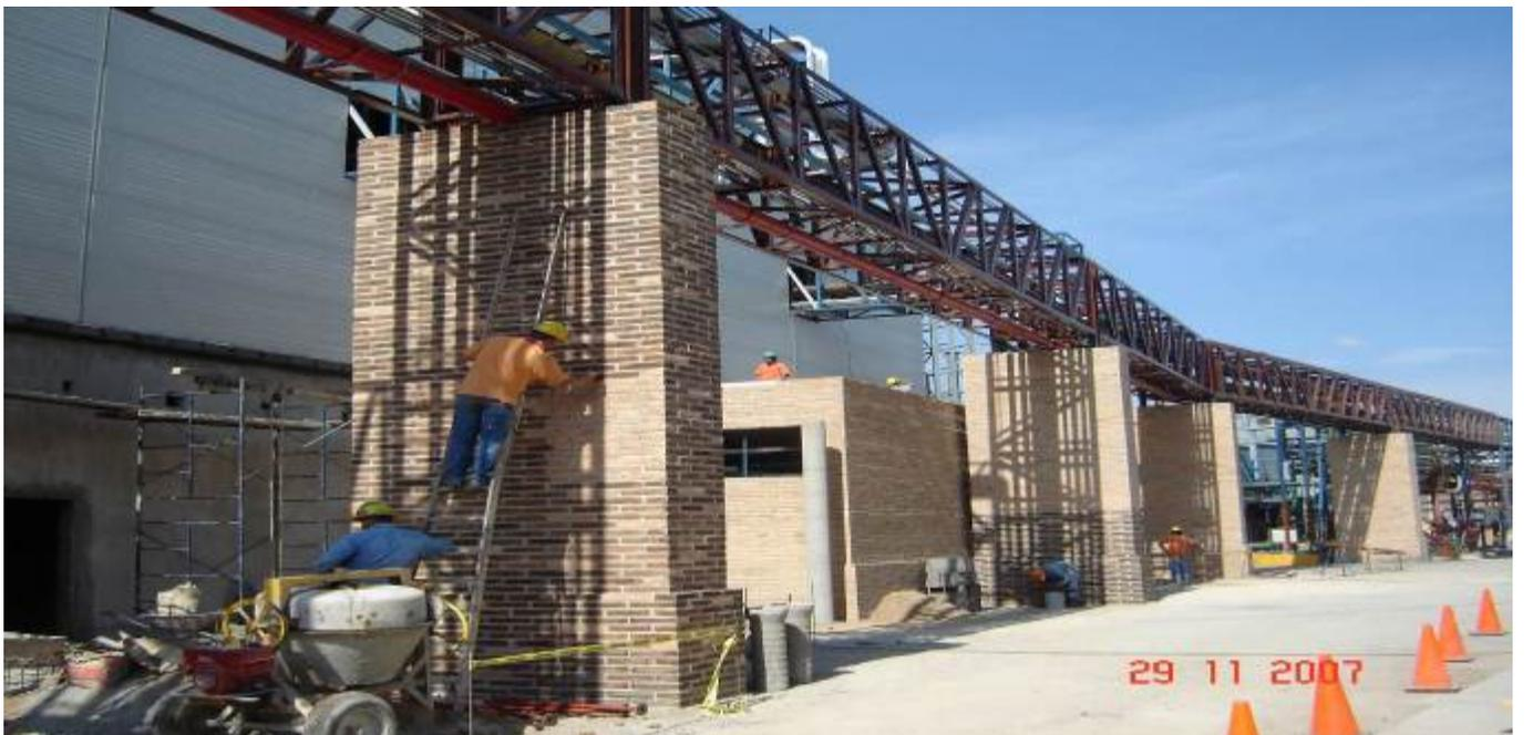
*Cimentación y obra civil de rack para tuberías*
