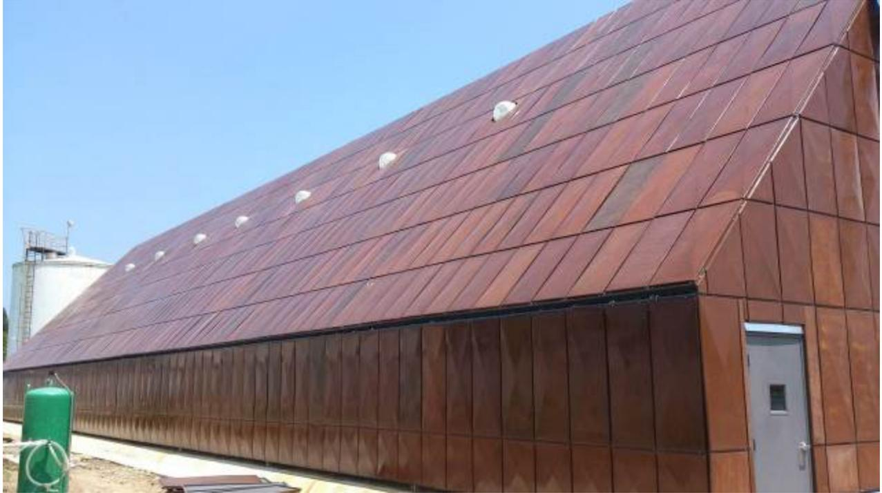
***Acabado exterior con módulos de lámina de acero acabado Oxidado***
