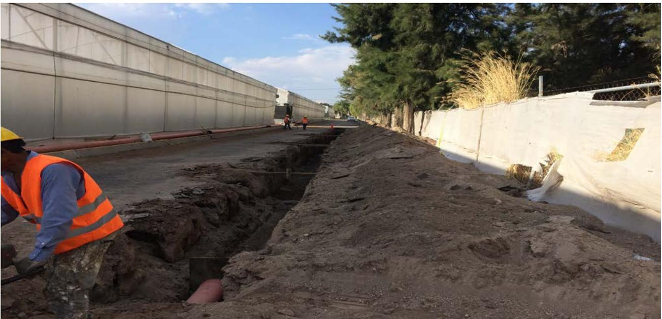
**COLECTOR DE DRENAJE DE RIEGO 16" 650 M EN NUCLEO DE INVERNADEROS.
